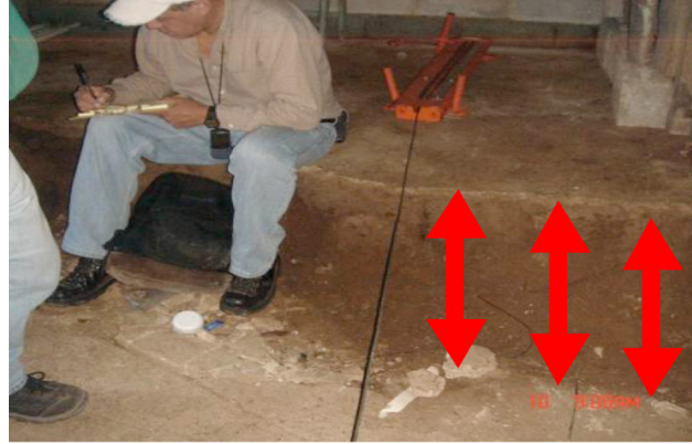
Fotografías 3 y 4: asentamiento diferencial por movimiento de masa en zona 1 de Mixco, Guatemala. Fuente: SE CONRED.
