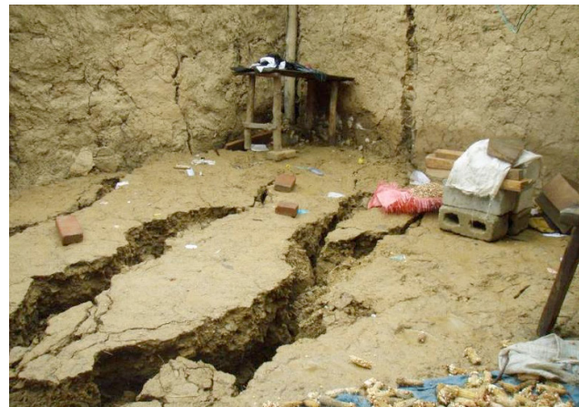
Es una abertura larga y estrecha producto de la separación de dos materiales Fuente: SE-CONRED.
