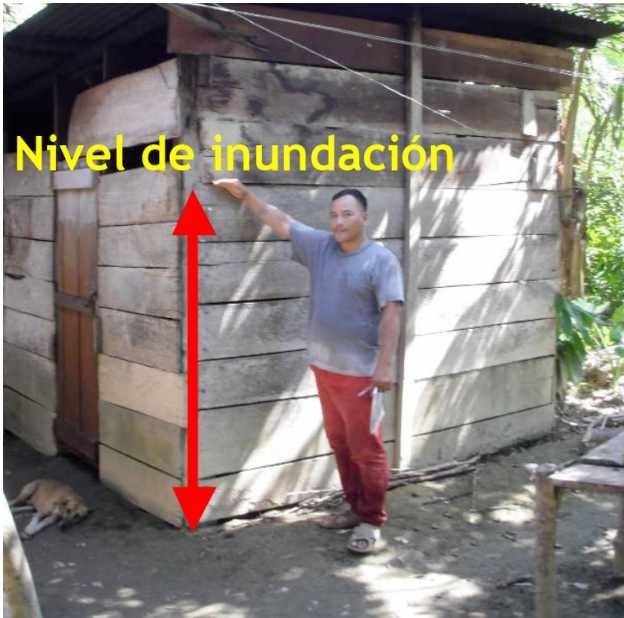
Fotografías 11 y 12: inundaciones costa sur Guatemala. Fuente: SE-CONRED.
