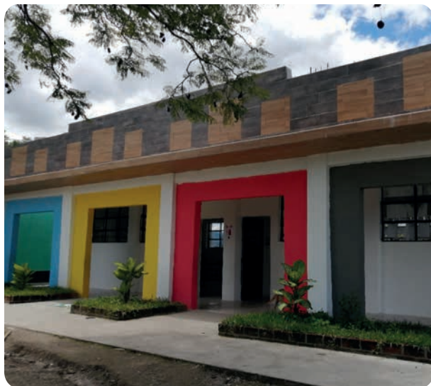
Ampliación Escuela Primaria San Andrés, Sajcabajá, Quiché
