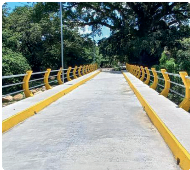
Mejoramiento de puente El Asintal, Retalhuleu
