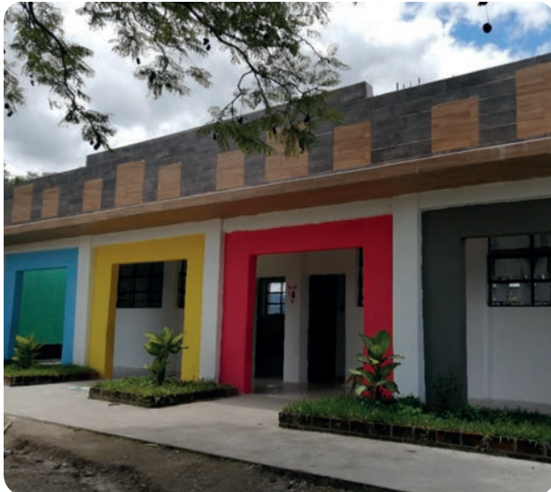
Ampliación Escuela Primaria San Andrés, Sajcabajá, Quiché
