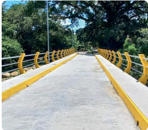
Mejoramiento de puente El Asintal, Retalhuleu
