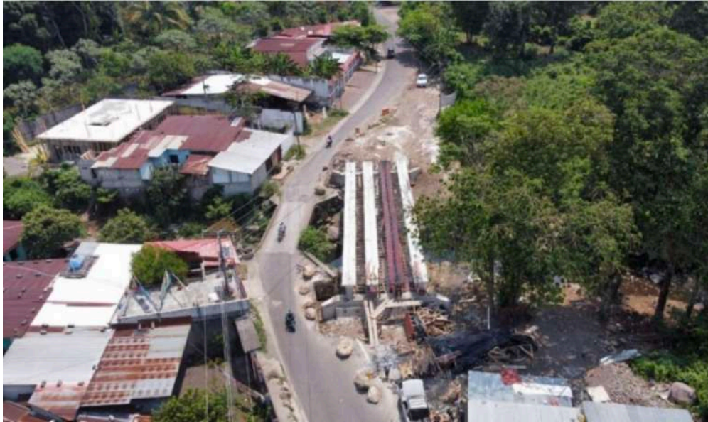
Imagen No. 14 Secretaría de Coordinación Ejecutiva de la Presidencia Monitoreo realizado al proyecto Construcción puente vehicular acceso a cantón Cocalles hacia aldea Tierras del Pueblo Mazatenango, Suchitepéquez, SNIP 262131
