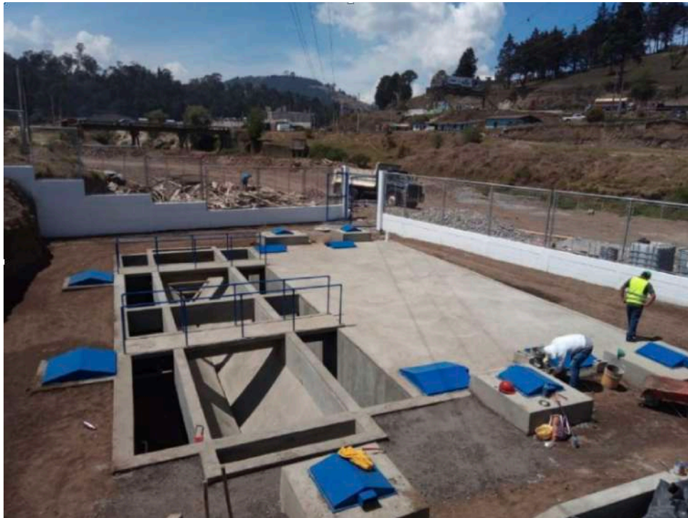
Imagen No. 15 Secretaría de Coordinación Ejecutiva de la Presidencia Monitoreo realizado al proyecto Mejoramiento al sistema de tratamiento aguas planta Los Cebollales, Panajachel, Sololá SNIP 242588
